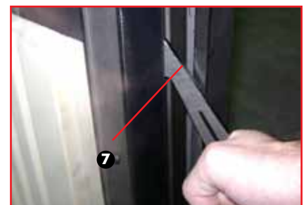
Figuur 4: vergrendeling gesloten deur (verankering 90° draai)
