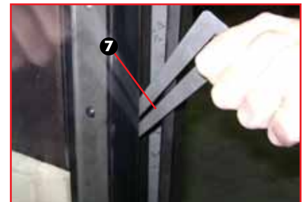
Figuur 3: vergrendeling open deur (verankering 90° draaien)
